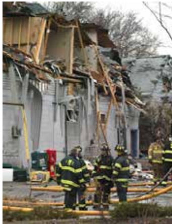
11. ábra. Oldószerrobbanás egy nyomtatófesték-üzemben – Danvers, MA, 2006. november [3]
